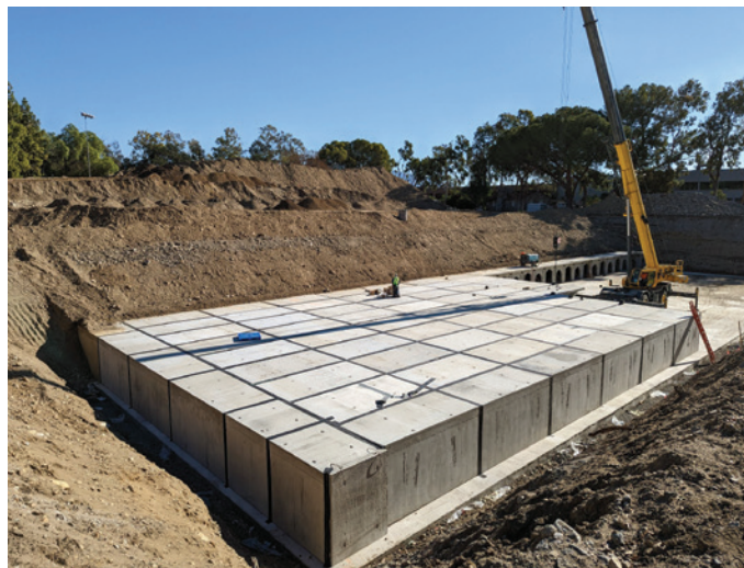
LA CIUDAD CONSTRUYÓ UN NUEVO SISTEMA DE INFILTRACIÓN DE AGUA
