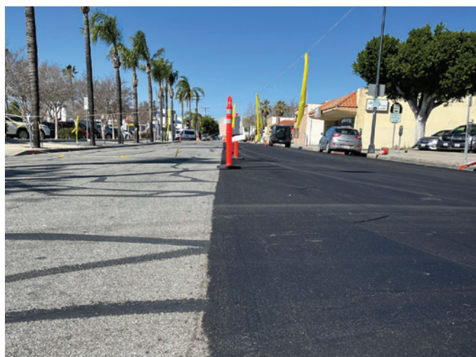
PROYECTO DE REPAVIMENTACIÓN MEJORA UNA CALLE DE LA CIUDAD
