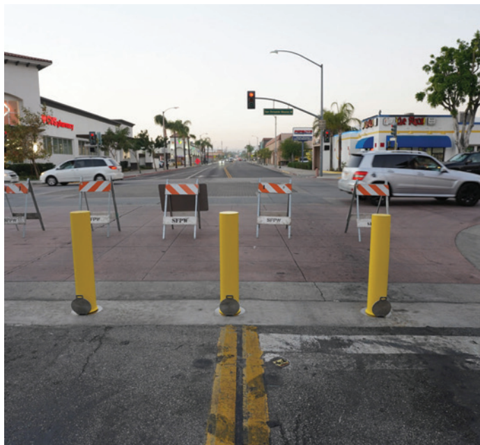
LOS BOLARDOS EN EL SUELO CREAN UN NUEVO ENTORNO PARA CAMINAR
